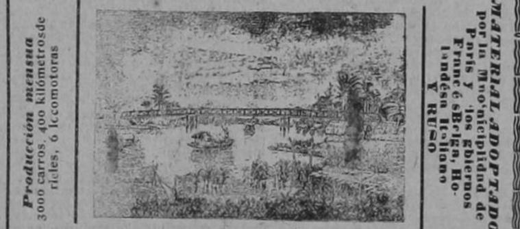
PUENTE DE 66 METROS EN DONG-NHYEN (Conchinchina) compuesto de 3 puentes de 22 metros, tipo 6 bis. Datos generales de un puente de 22 metros: Anchura disponible 3 mts. Carga por metro cuadrado 300 k. Largo mínimo que se contruyó 900 k. Carga por metro lineal 19900 k. Peso del elemento más pesado 162 k. Carga total máxima 6000 k. Largo del elemento más grande 6 m. Carga redante máxima 484. Agente general en Costa Rica. LUCIANO ROJAS, apartado 484.
